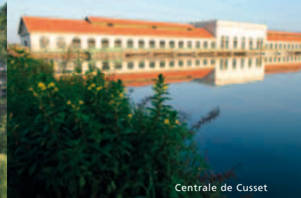
Centrale de Cusset
