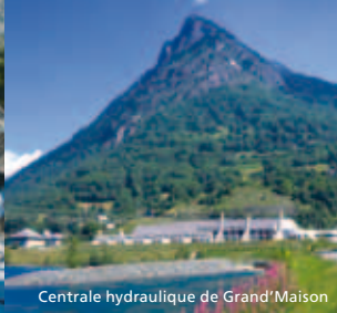
Centrale hydraulique de Grand'Maison
