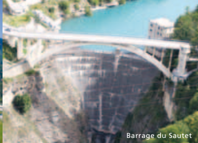
Barrage du Sautet
