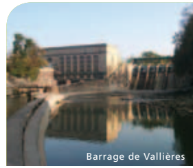
Barrage de Vallières
