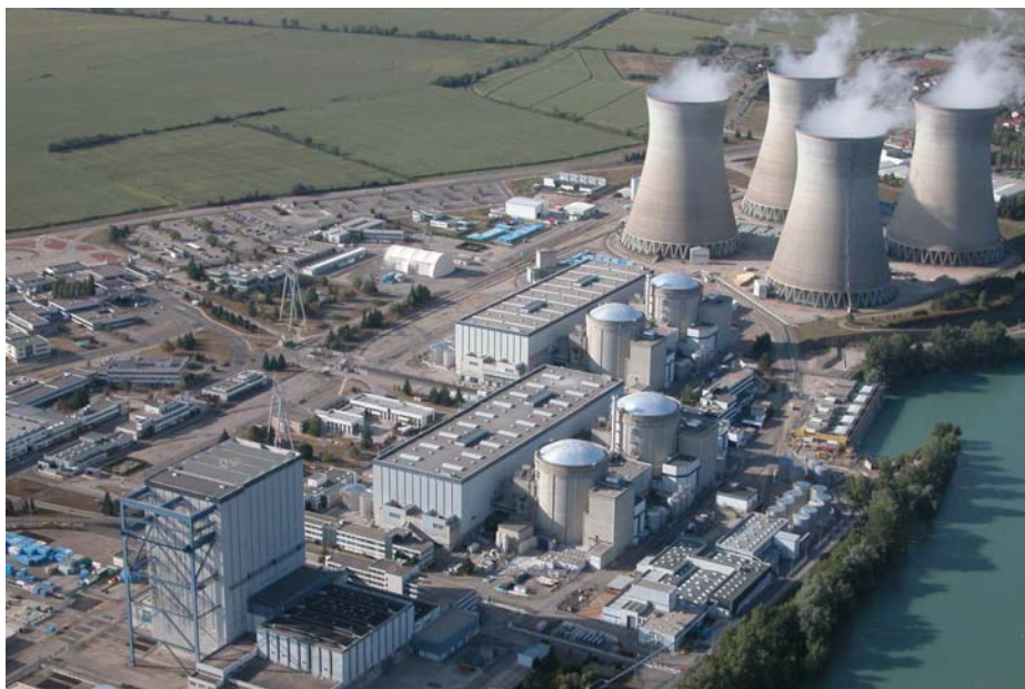
La centrale nucléaire du Bugey est composée de 4 unités de la filière « réacteurs à eau pressurisée » (REP) en fonctionnement et d'une unité de la filière graphite gaz (UNGG) en déconstruction.
