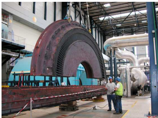
Préparation d'un chantier en salle des machines.
