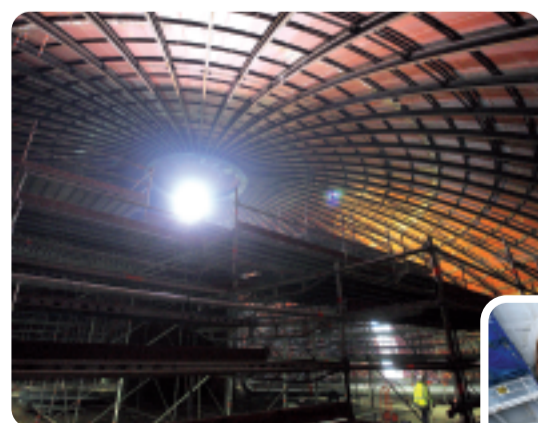
Vue intérieure du dôme sur sa zone de préfabrication
