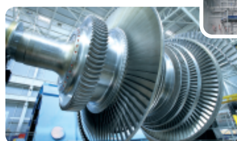
Mise en place des ailettes du rotor basse pression en salle des machines
