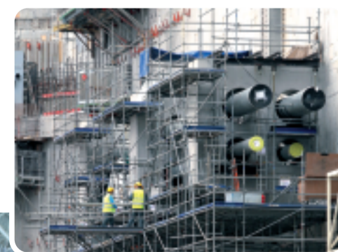
Mise en place de tuyauteries dans les cadres anti-fouettement de l'îlot nucléaire : • la tuyauterie située au dessus véhicule la vapeur issue des générateurs de vapeur vers la turbine, • la tuyauterie située au dessous véhicule l'eau alimentaire provenant du condenseur pour transformation en vapeur dans les générateurs de vapeur
