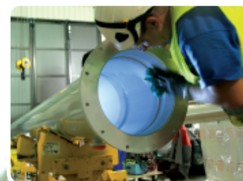
"Poste sous Enveloppe Métallique" qui abrite l'ensemble des éléments haute tension de Flamanville 3 dans une enveloppe métallique placée sous gaz inerte. Le salarié inspecte une portion de l'enveloppe métallique avant la mise en place de la barre conductrice supportant la haute tension.
