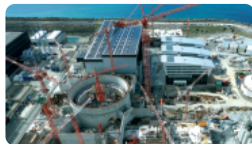
Vue générale Est/Ouest.
