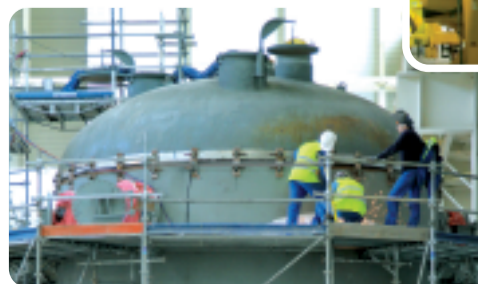
Pose et réglage du fond plein (couverture) d'un des deux groupes sécheurs surchauffeurs en salle des machines.
