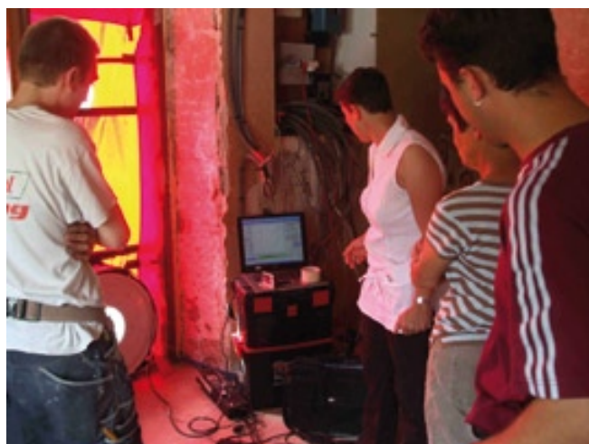
Test d'échanchéité à l'air après travaux
