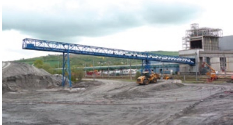
Convoyeur de cendres fourni par la société RIB (52) à la centrale thermique de Blénod
