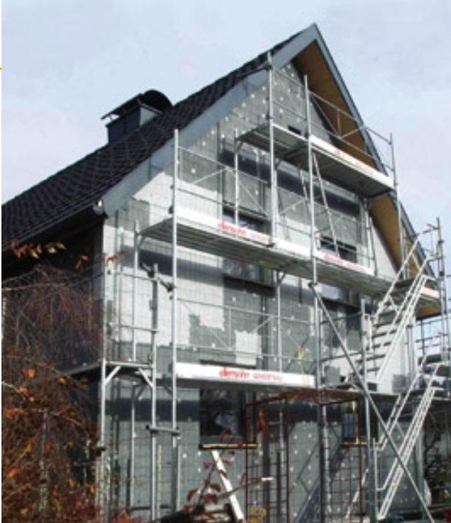
Réalisation de l'isolation extérieure d'une maison
