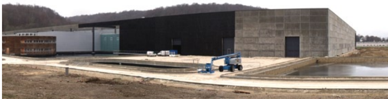
Le chantier à fin 2010
