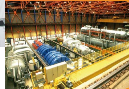
Salle des machines avant travaux
