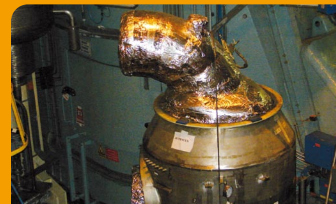
Tête d'un échangeur intermédiaire
