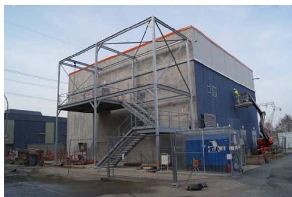
Début 2011 : sortie de terre du nouveau bâtiment électrique
