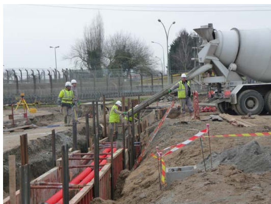
2010 : début des travaux de génies civils (terrassement, fondations etc.)
