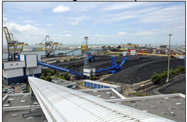
>La capacité du parc de stockage est de 350 000 tonnes soit un mois de consommation pour 3 unités de production en fonctionnement continu.
